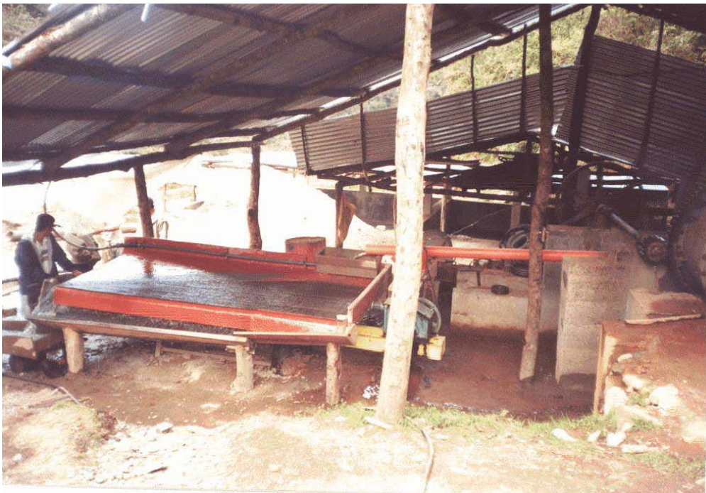
Figura 49b). Instalaciones mina El Diamante: mesa de concentración y al fondo tanque de cianuración.
