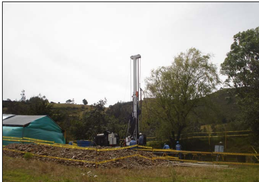
Figura 20. Montaje del Pozo Socotá-2, Vereda Parpa, municipio de Socotá.
