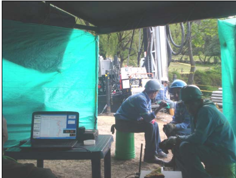
Figura 23. Toma de registros en el Pozo Socotá-2.
