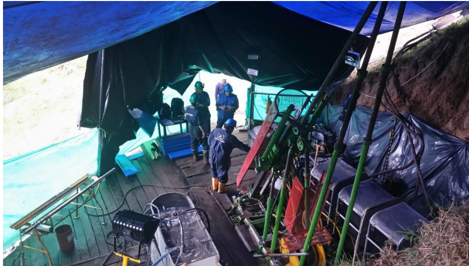
Figura 26. Montaje del Pozo Úmbita -1, Vereda Juncal, municipio de Úmbita.
