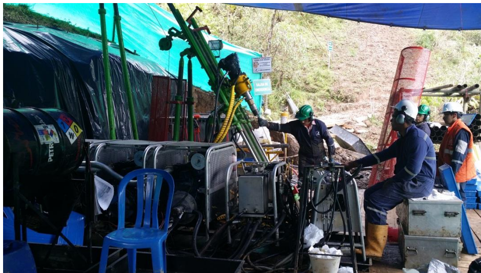
Figura 29. Montaje del pozo Chinavita-1.
