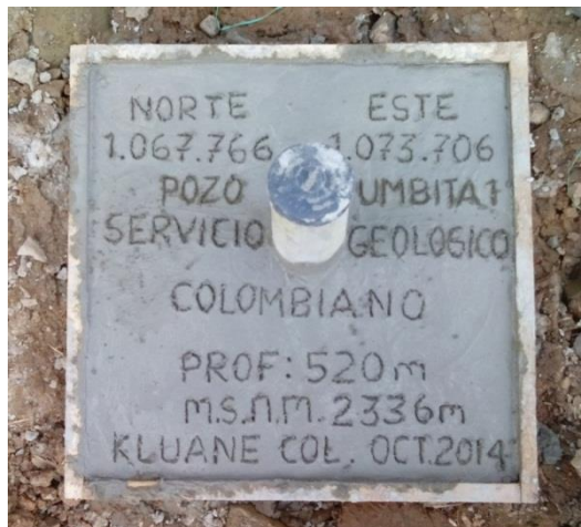
Figura 31. Sellado del Pozo Úmbita -1, municipio de Úmbita .
