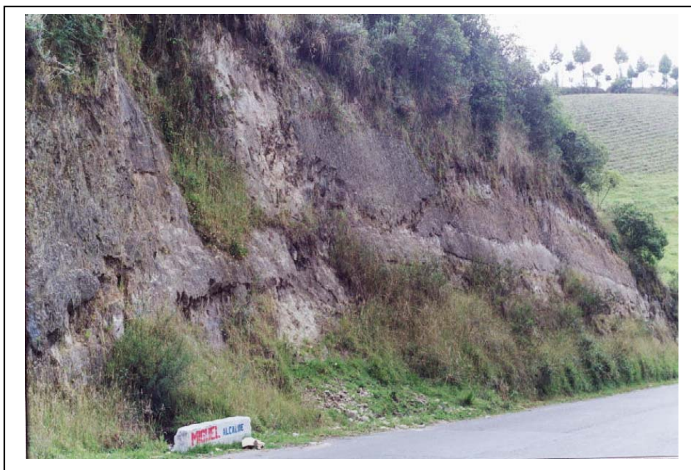
Figura 29. Depósito de Cenizas de Rumichaca. Carretera Ipiales - Pupiales
